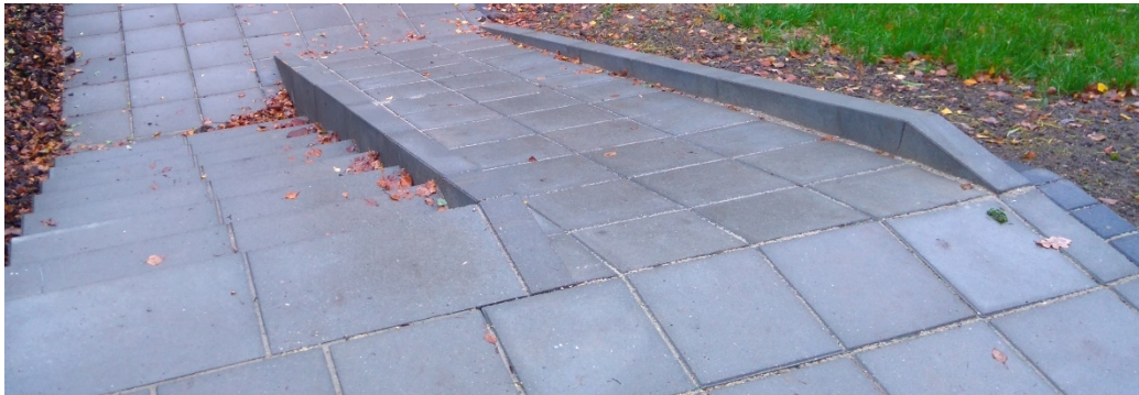
Fig. 3: Eksempel på en rampe etableret med fliser.
