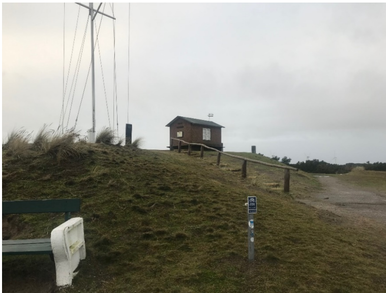
Fig. 4: Lodshus og trappe set fra betonvejen.
